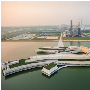
白色现浇混凝土 ——江苏淮安实联化工水上办公楼
