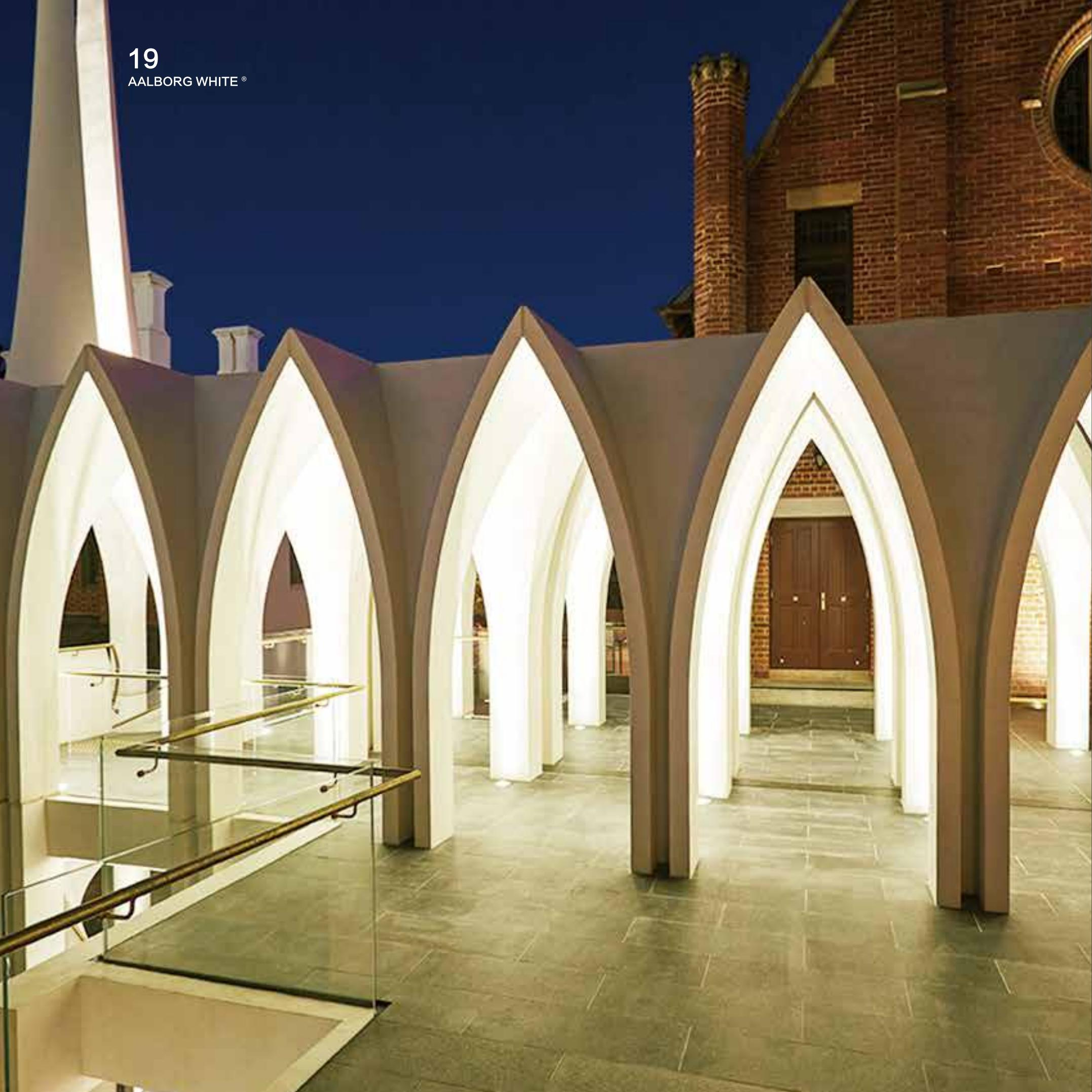
由于项目建于现有建筑之间,这对装配预制混凝土构件构成了重大挑战,因为构件需要用卡车起吊60米高度,然后才能达到最终位置。尽管施工难度很大,但这不影响建筑物的整体美观度。由阿尔博®白水泥制成的优雅白色预制混凝土立面、由U形柱支撑的白色混凝土尖顶拱门形成的柱廊,以及卡多安唱诗班学校的每一个独特设计都受到大教堂柳叶窗的启发。
