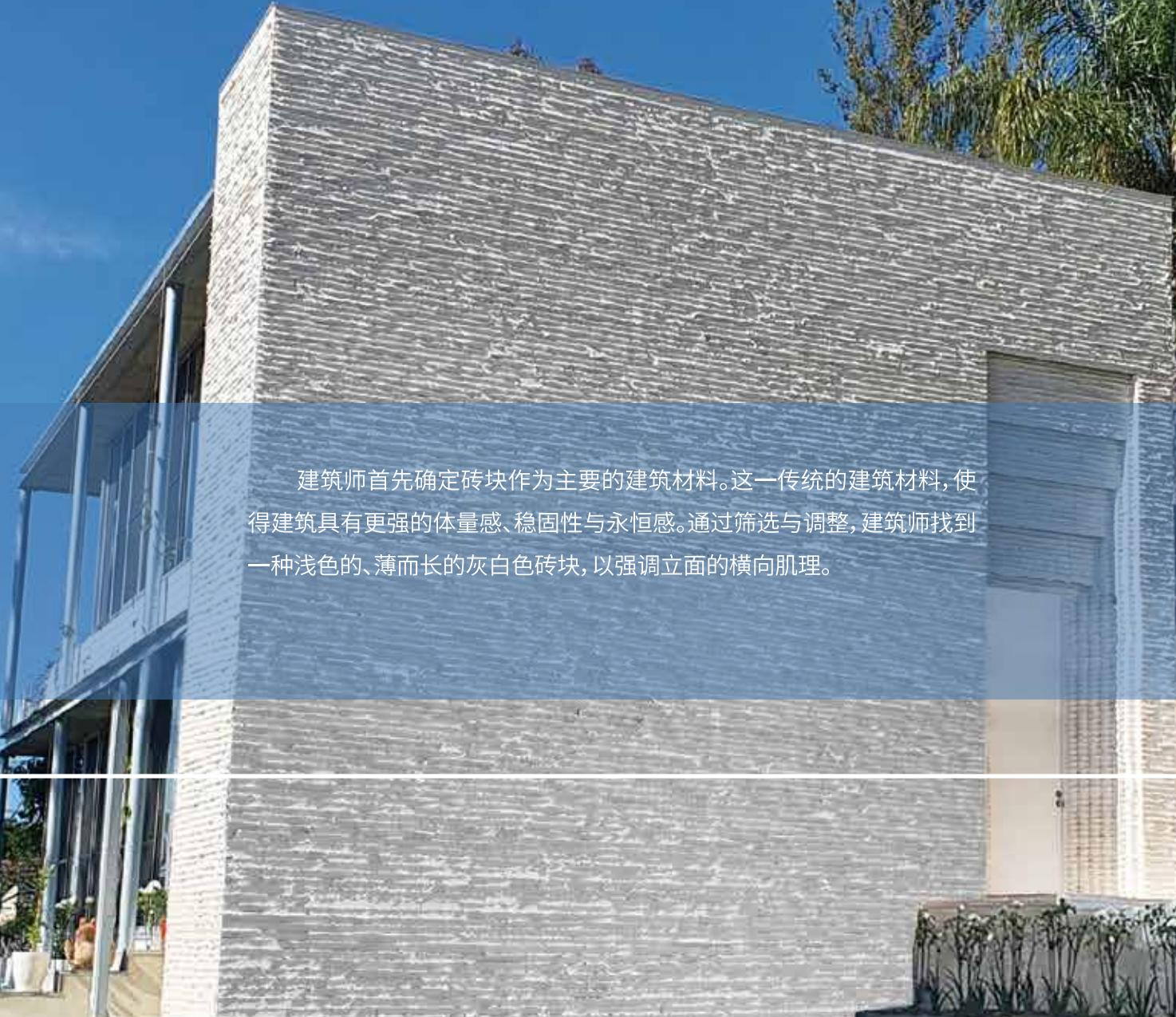
建筑师首先确定砖块作为主要的建筑材料。这一传统的建筑材料，使得建筑具有更强的体量感、稳固性与永恒感。通过筛选与调整，建筑师找到一种浅色的、薄而长的灰白色砖块，以强调立面的横向肌理。
