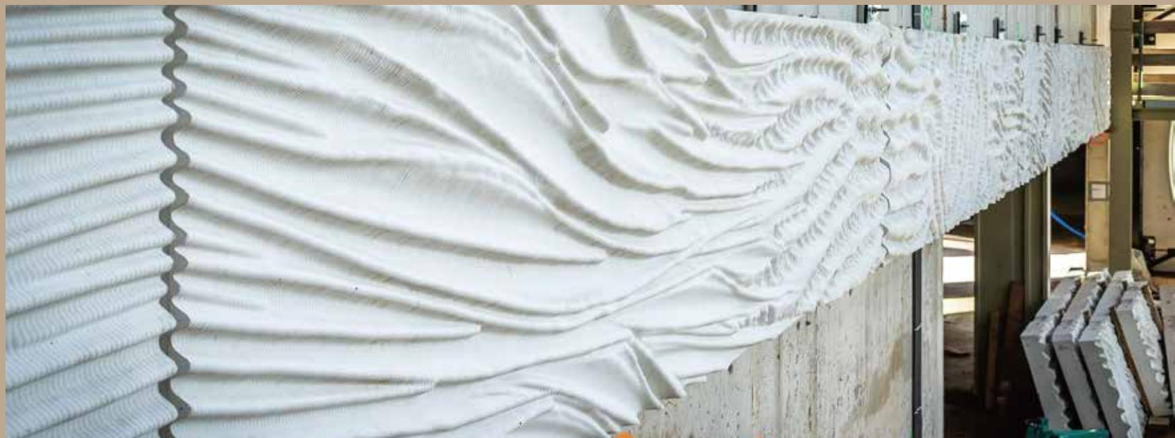
在此项目中,不同尺寸的白色混凝土构件发挥着不同作用。大尺寸的构件通过预制的皇冠状混凝土构件可以发挥结构作用,同时形成的细腻曲面,丰富了单元化立面的效果。小尺寸的装饰带充分发挥了混凝土的可塑优势,纹理细腻丰富。在不同尺寸上,全面地体现了装饰混凝土的强大可塑性。
