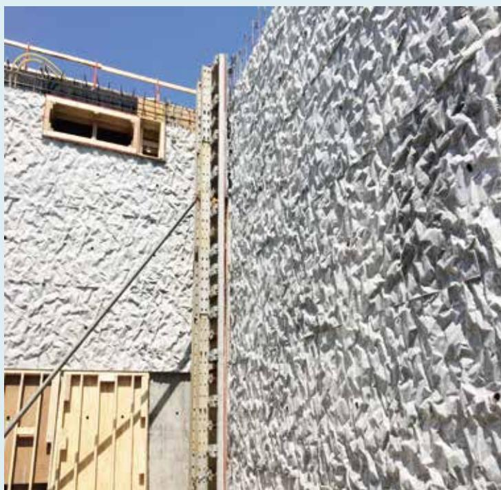
为确保THE REACH艺术中心演出时卓越的音质和控制效果,建筑物内部设计考虑的很周全,使得多个演出可以同时举办,而不会互相干扰。约11570平方英尺的垂直墙面空间采用定制的“皱褶混凝土”纹理,可以打破声波并避免平行墙之间的混响。这一独特的形式来自建筑师的物理弯曲金属板,以创造一个不规则的褶皱纹理,然后进行硅胶翻模,以现场浇筑方式建造出具有功能性的混凝土内墙。因此,这些墙既作为装饰墙,也是建筑的主要承重结构。设计师的技巧在于如何将不同的形式、饰面和纹理与物理布局结合起来,将许多功能空间分隔开来,同时提供一种和谐的、有感召力的游客体验空间。
