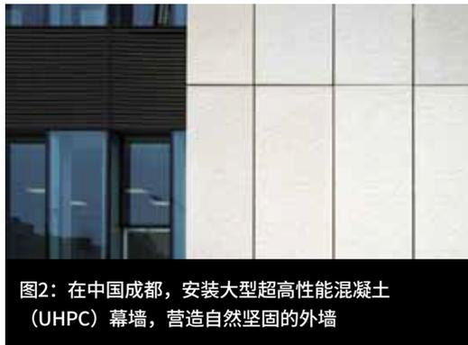
图2：在中国成都，安装大型超高性能混凝土（UHPC）幕墙，营造自然坚固的外墙
