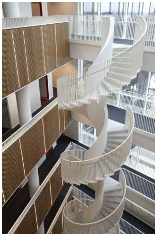
丹麦Per Aarsleff写字楼的超高性能混凝土（UHPC）楼梯
