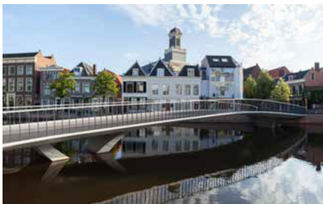
荷兰莱顿市的超高性能混凝土（UHPC）桥梁
