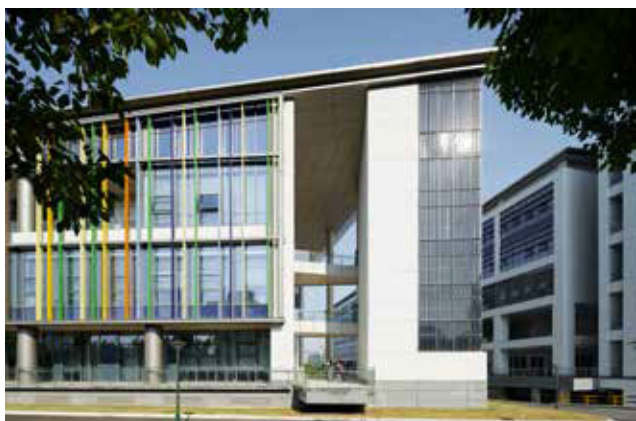
中国南京医科大学的超高性能混凝土（UHPC）装饰板
